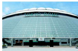
東京ドーム様 監督室、ロッカールーム、観客トイレなど114台導入
